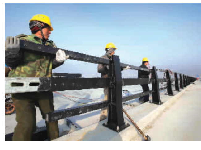
1月2日,在连云港跨海大桥施工现场,施工人员正在安装护栏。元旦期间,连百名建设者奋战在我市重点工程跨海大桥建设现场,力争大桥早日通车。
