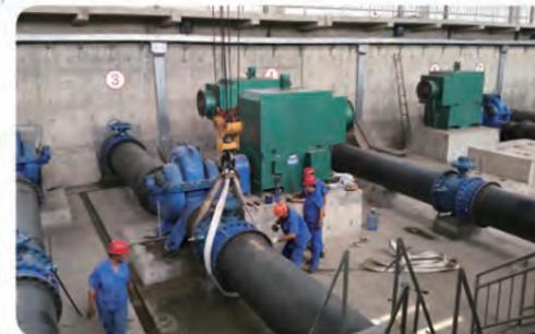
沐新渠泵站新增4套旋转滤网设备
